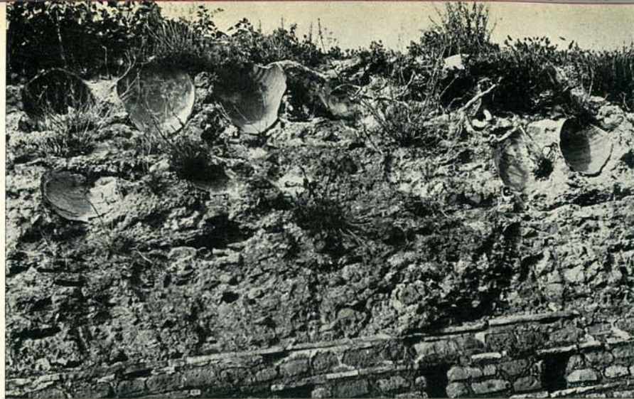
Esempio di costruzione romana: le anfore al posto dei mattoni vuoti per sostenere le scale.
