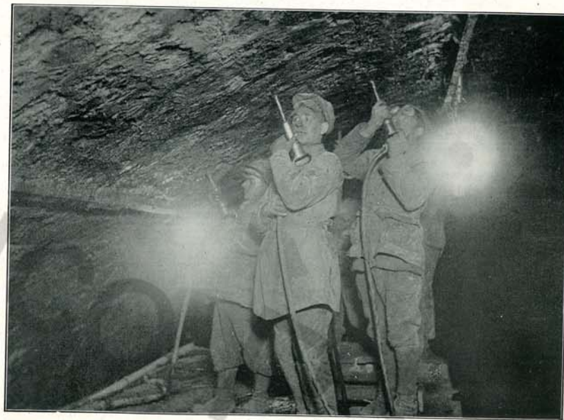
Lavoro preliminare di pulitura effettuata con martelli ad aria compressa per la impermeabilizzazione di gallerie ferroviarie da elettrificare con tensione di 15.000 Volts.
