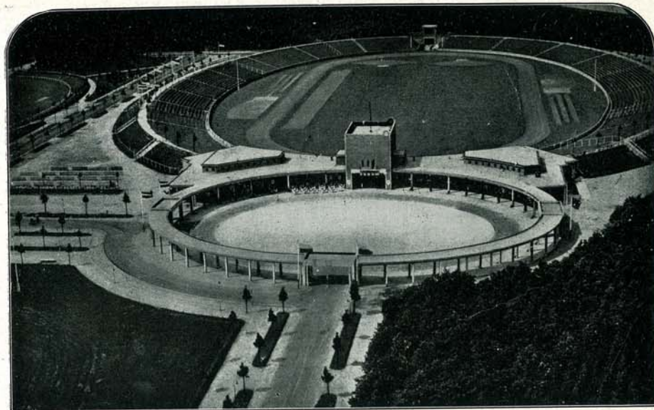
L'arena centrale dello stadio di Breslavia.
