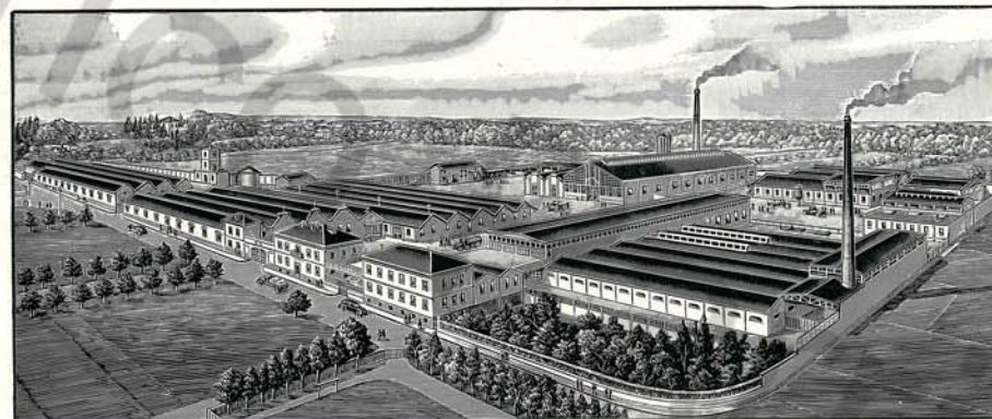
VEDUTA GENERALE DELLO STABILIMENTO "REJNA,, (IERAGO - VARESE)
