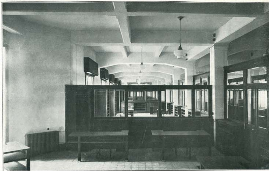
Le teorie passatiste debellate nell'originale e magnifico interno della sede del Ministero dell'Aeronautica. I muri separatorii sono sostituiti da tramezze razionali, permettendo un'igiene perfetta di aerazione e un controllo costante.
