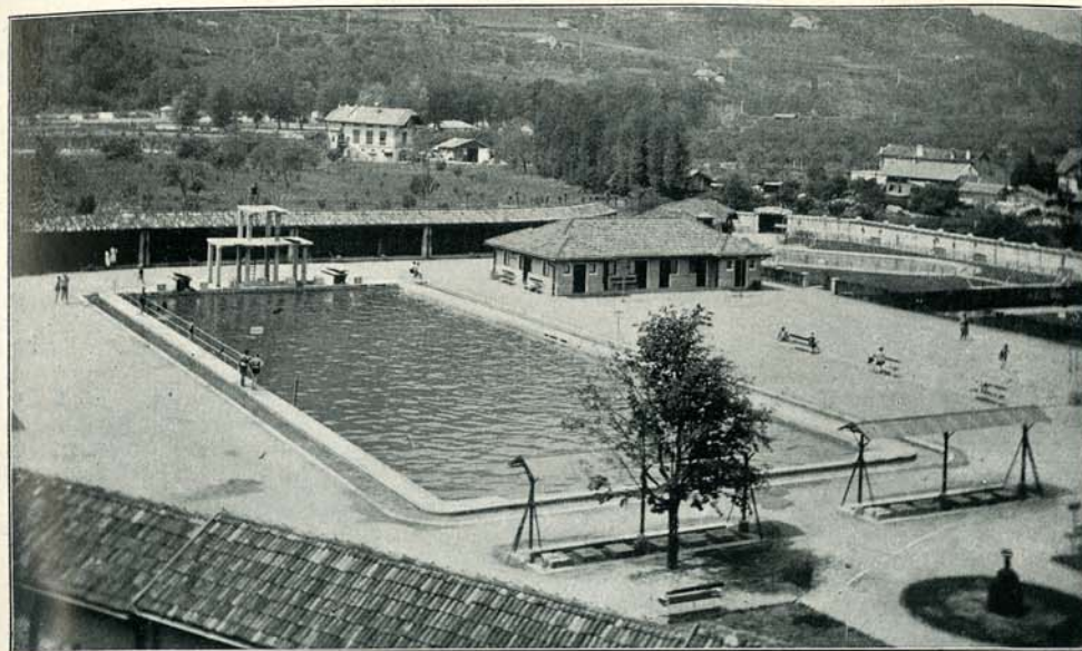
La piscina costruita a Merano dal Comune ed inaugurata il 24 dello scorso maggio. Da notarsi il canaletto d'acqua sulla perimetria del bacino per la pulizia dei piedi di chi deve entrare in acqua.
