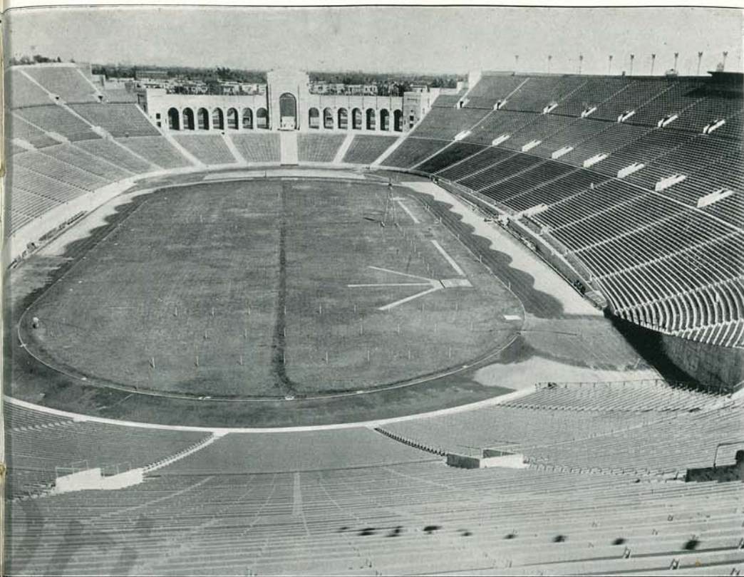
Veduta nel suo complesso, l'arena che è stata costruita a Los Angeles per ospitare i Giochi Olimpici del 1932 è davvero imponente. Osservatela dall'alto, a costruzione finita.
