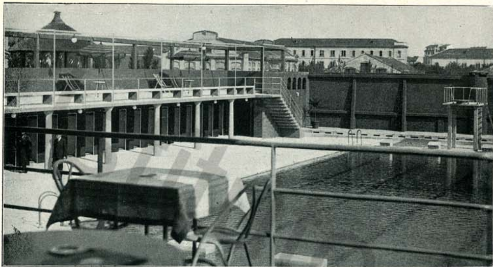
La piscina del Tennis Club Milano architettata da Giovanni Muzio. Nel suo breve spazio questo bacino è tecnicamente perfetto: in fondo il trampolino coi piani elastici in acciaio per i tuffi da 1 e da 3 metri. A sinistra le cabine e la terrazza dei bagni da sole. La vasca misura m. 12 x 25, può ospitare contemporaneamente quattro nuotatori e fare omologati i tempi in essa ottenuti sulle distanza sino a 800 metri (foto Argo).
