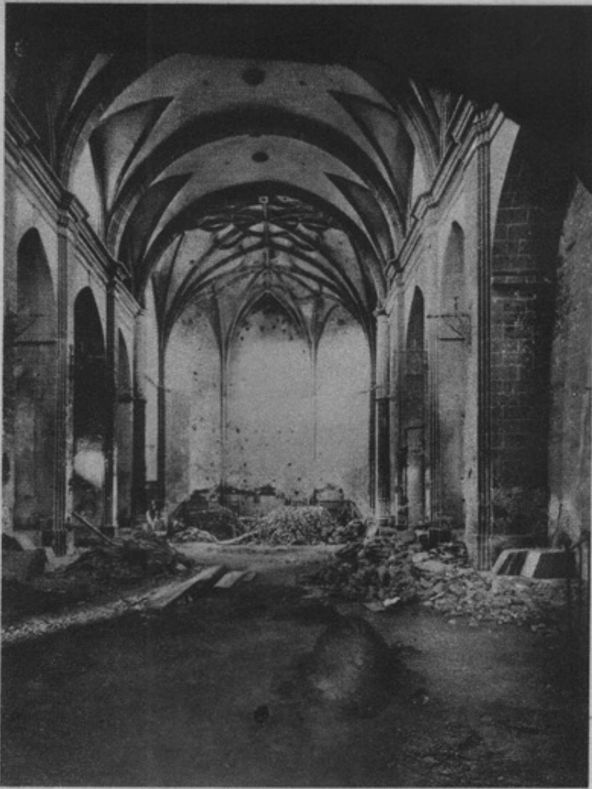
Ce qui reste de l'église gothique d'Almendralejo transformée en garage. (Province de Badajoz.)
